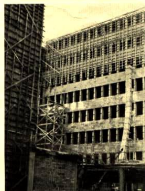
Överst: exteriör av postgirots hus dit vi levererat alla snickerier. Nedtill: Thulehuset under byggnad till vilket vi också äro leverantörer.
